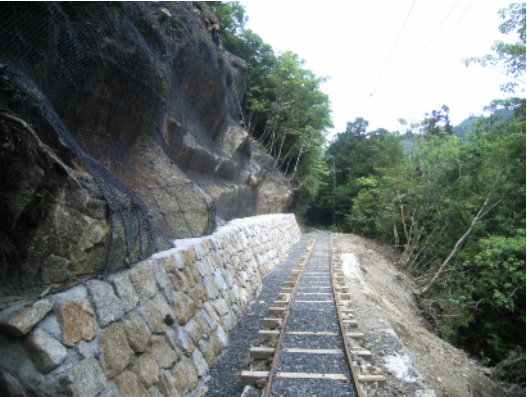
(復旧工事終了後)
