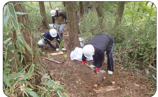
歩道補修作業の様子
