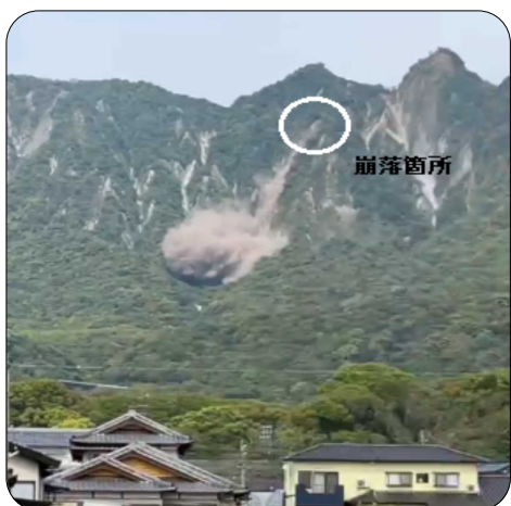
崩落直後の眉山2溪（写真：市民提供）
