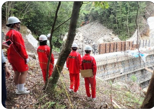
谷止工の工事箇所を見学
