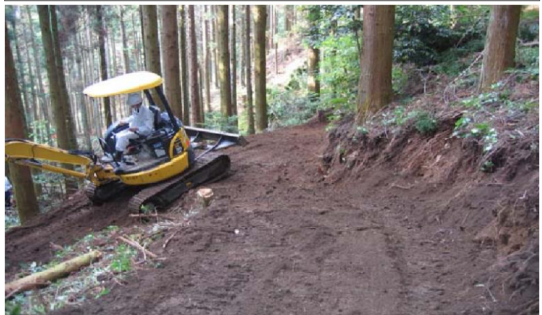
新スイッチバック作設状況
