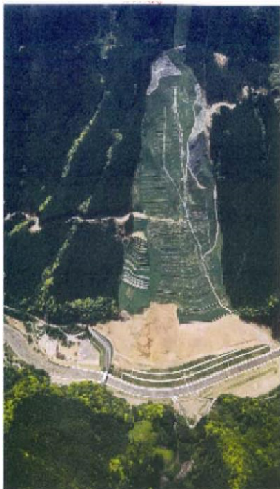
復旧完了後の状況
