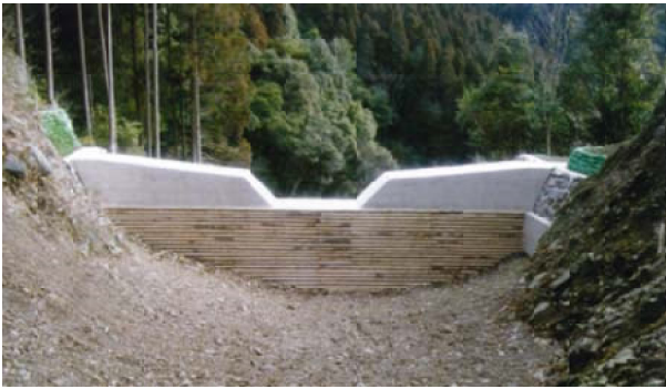
← 丸太残存型枠
