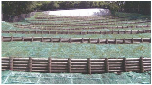
← 丸太残存型枠
