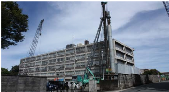
耐震改修工事中の局庁舎
