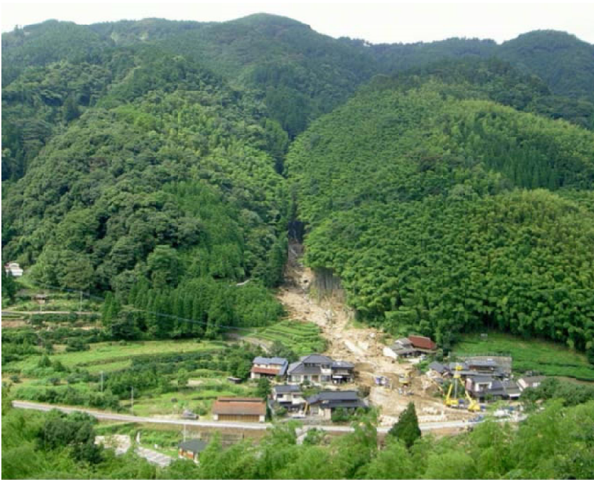
集中豪雨により発生した被害状況（佐賀県吉野ヶ里町）
