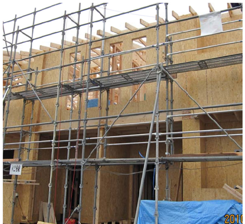
スギ材を部材に使用した2×4住宅
