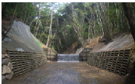
間伐材を使用した床固工等
