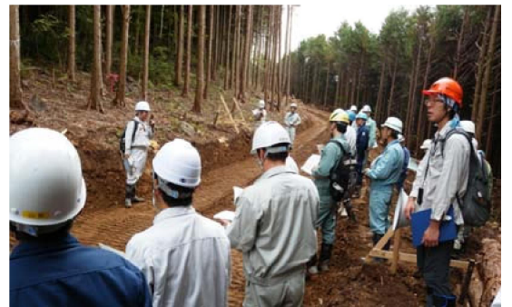
開設中のモデル路線での線形の検討状況
