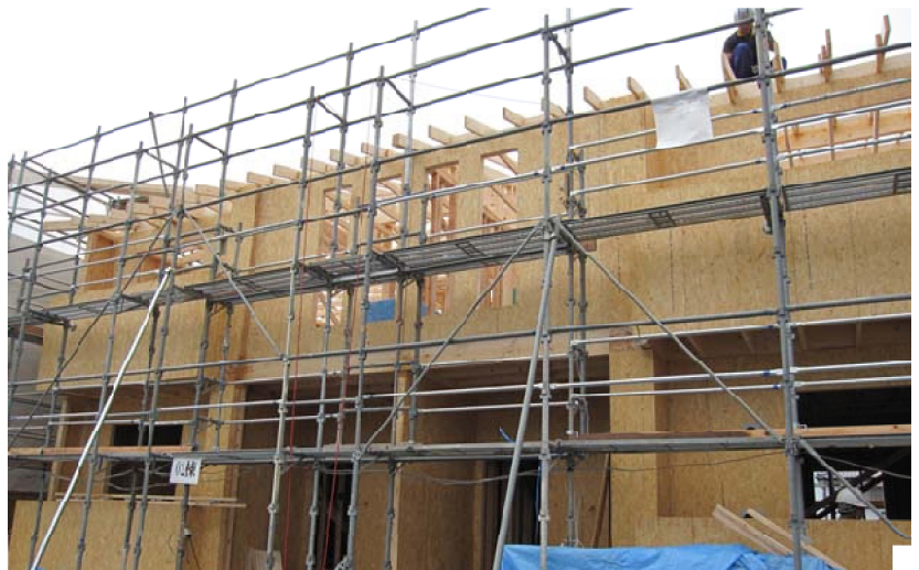
建設中の2×4住宅
