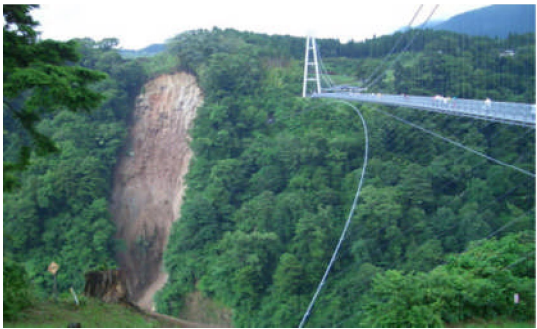
大分県九重町で発生した崩壊地
