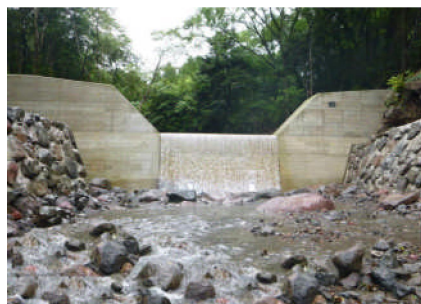
高崎川流域に完成した治山ダム（小林市）
