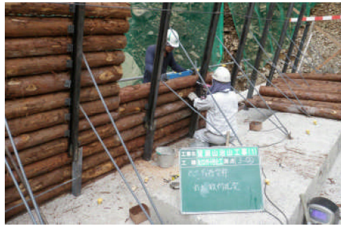
丸太残存型枠の施工状況
