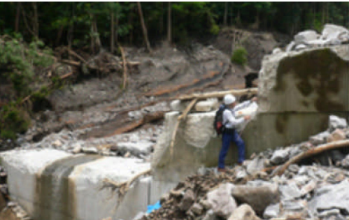
治山施設の点検調査状況
