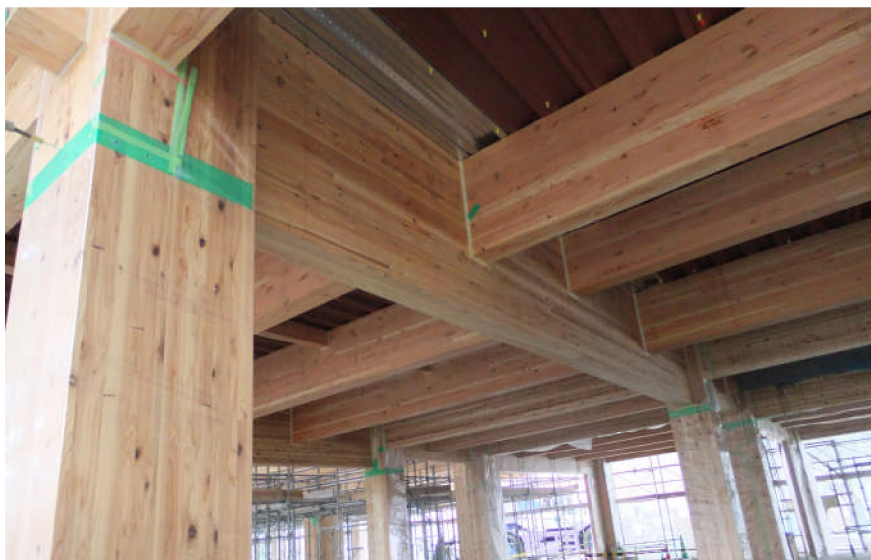
木造公共建築物（上天草市松島庁舎兼保健センター）近景内部構造材
