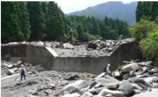
治山施設の点検調査状況
