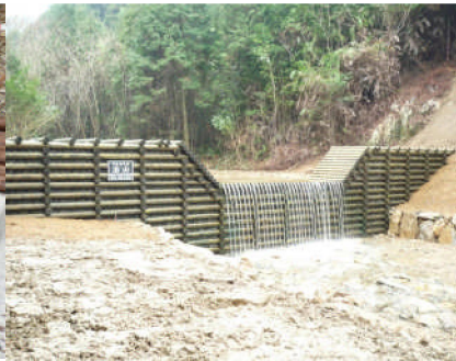
間伐材を使用した床固工（五島市）
