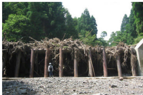
治山施設の点検調査状況
