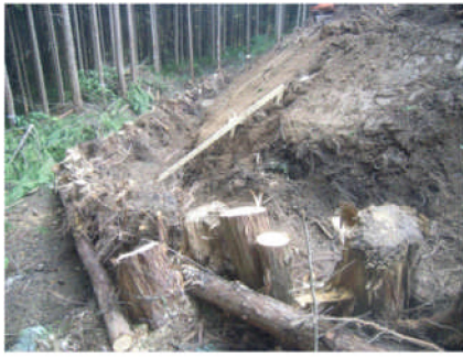
施工した主な工種（法面保護工）
