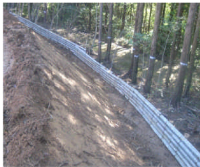
施工した主な工種（竹柵工）
