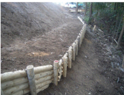
施工した主な工種（木柵）
