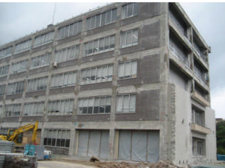
外壁改修工事の様子（平成22年8月）
