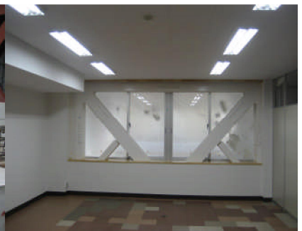
室内から見た鉄骨ブレース設置状況
