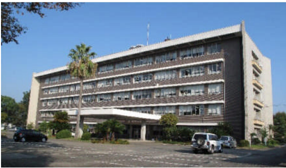
耐震工事着手前の旧庁舎
