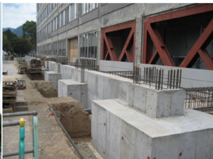
基礎工事の様子（平成22年10月）
