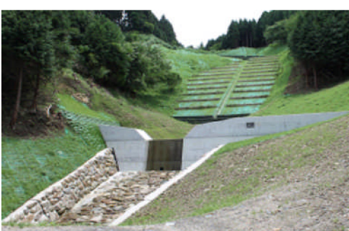
山腹工（福岡県嘉麻市）
