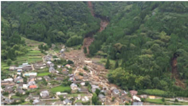
山地災害の状況（熊本県阿蘇市）
