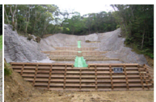
山腹工（鹿児島県奄美市）
