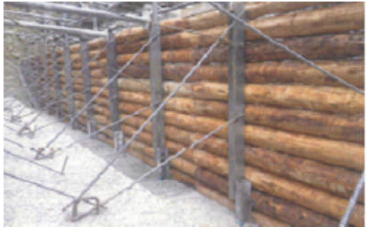
丸太を活用した型枠施工事例（丸太残存型枠）
