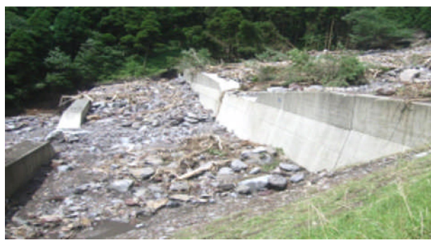
土石流を抑止した治山ダム
