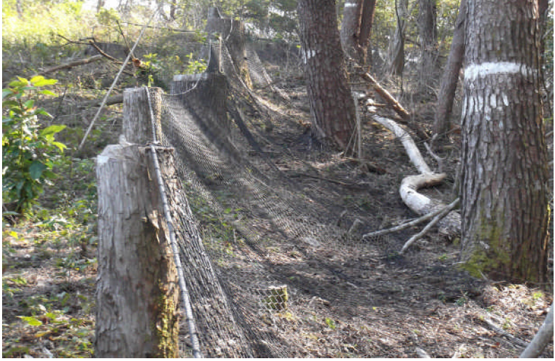
林縁木利用の斜め張り
