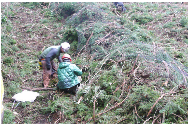
防護柵の寝かせ張り
