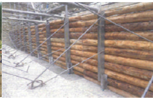
丸太を活用した型枠施工事例（丸太残存型枠）
