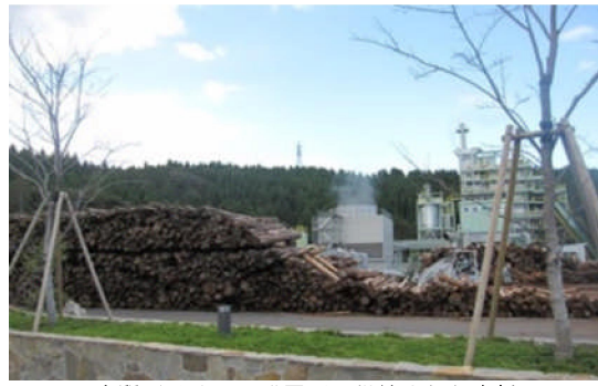
木質バイオマス発電所へ供給された木材
