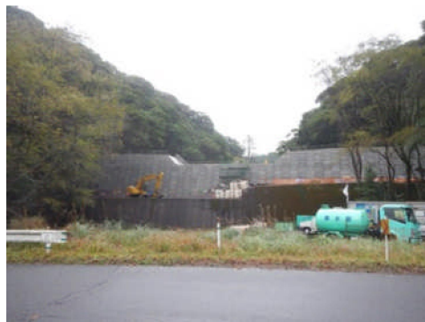
H27 荒襲治山工事 (都城支署)
