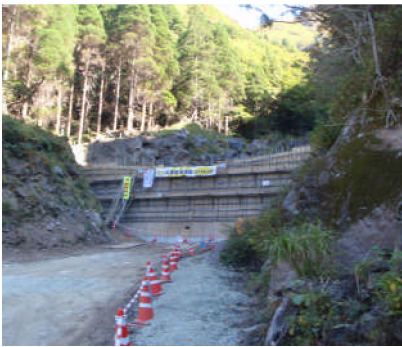
H27 猫岳治山工事 (熊本署)
