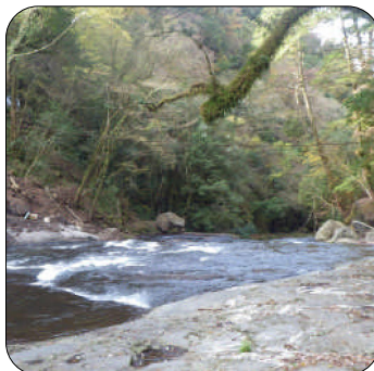
溪流内復旧状況
