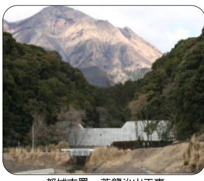
都城支署：荒襲治山工事
