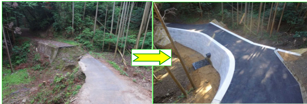
写真-7, 8 被災後と復旧工事完成状況 (鬼ヶ城林道)
