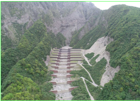
溪間工の設置状況（長谷川）
