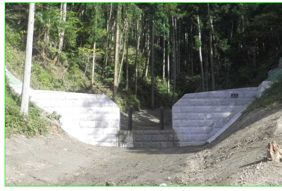
流木補足式谷止工の完成状況
