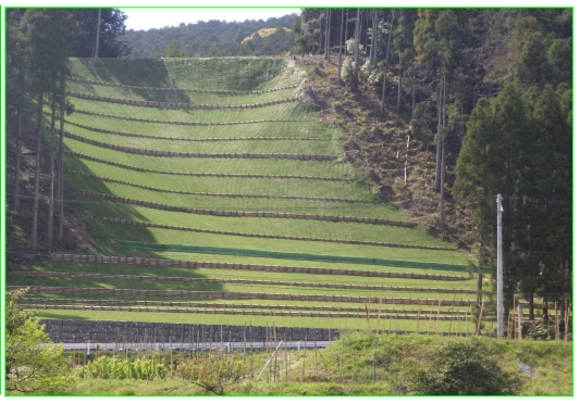
山腹工の完成状況
