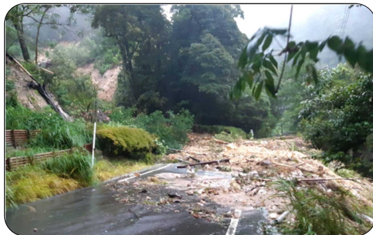
令和4年台風14号による林地被害状況（鹿児島県霧島市）
