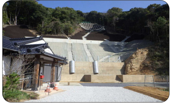
山腹工の完成状況（熊本県芦北町（民有林））
