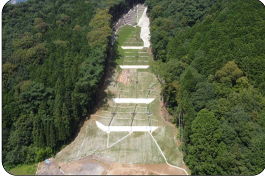
山腹工の完成状況（熊本県芦北町（民有林））
