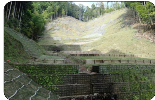
山腹工の完成状況（福岡県朝倉市（民有林））
