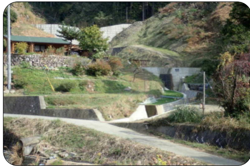
溪間工の完成状況（福岡県朝倉市（民有林））
