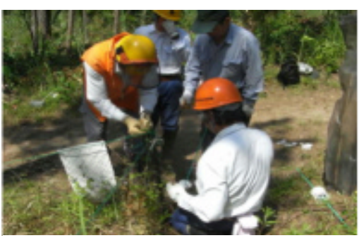
ウサギ被害防止ネット補修に汗 = 宮崎北部
