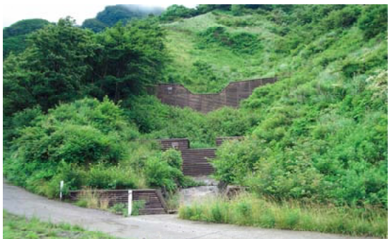
平成20年復旧状況（同上箇所）
