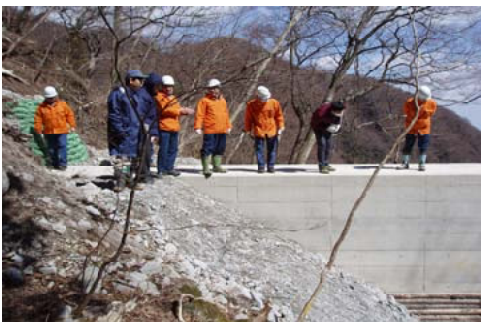
完成した堰堤を見学する参加者＝大分西部
