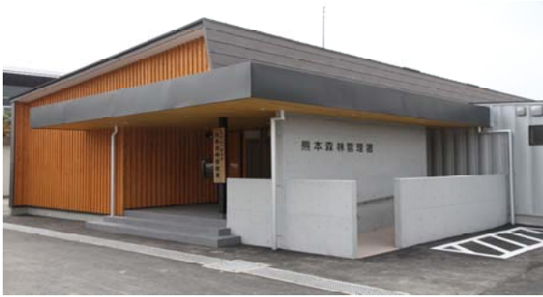
完成した新庁舎＝熊本森林管理署
