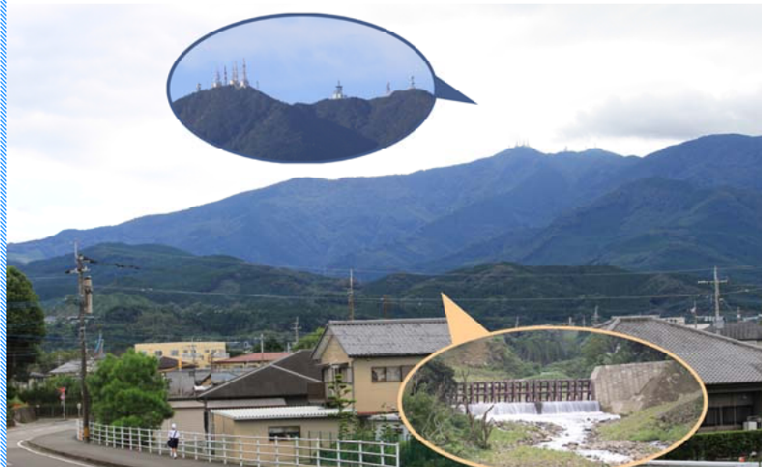
事務所から見上げた鰐塚山（上）山頂の様子・（下）治山工事堰堤
