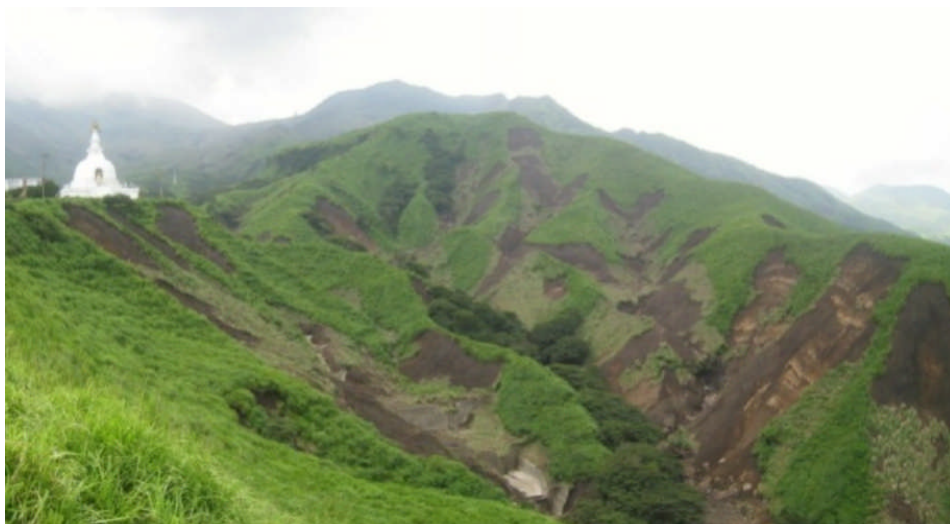
九州北部豪雨で発生した仙酔峠付近の被害状況＝阿蘇市
