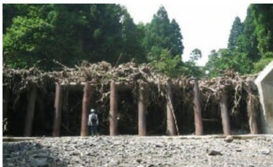
流木を抑止したスリットダム＝黒川本流
