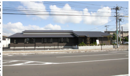
日田の町並みに合わせた切妻風屋根の新庁舎
