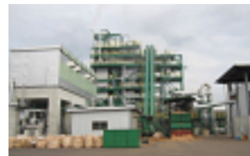
木質バイオマス発電施設(大分県日田市)
