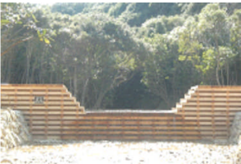
平成25年度川原地区（長崎県五島市） 【木製床固工：木材使用量44.8m 3 】
