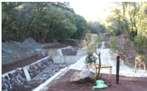
平成25年度楽之浦地区（宮崎県小林市） 【流路工の壁面に現地で発生した土石を使用】
