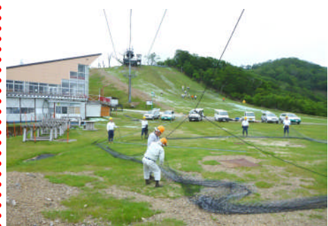
囲いわなを設置する職員＝宮崎北部
