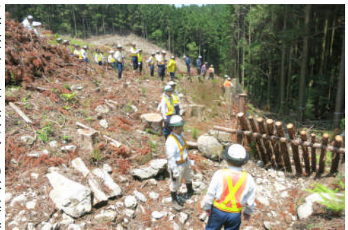
現地検証をする参加者＝熊本南部
