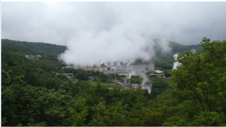
八丁原地熱発電所の全貌
