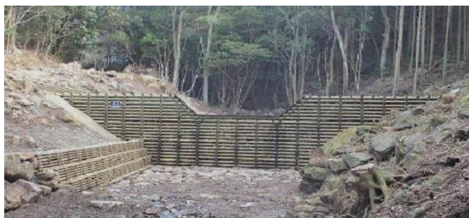
平成26年度 木製床固工（鹿児島県出水市） 【木材使用量 29m3】
