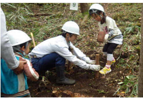
階段設置のため杭打ちをする子ども
