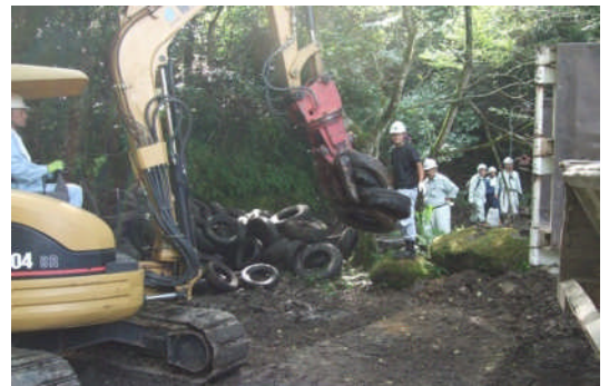
大量に捨てられたタイヤを重機で回収
