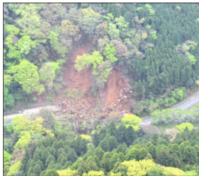
被害状況(国有林)
