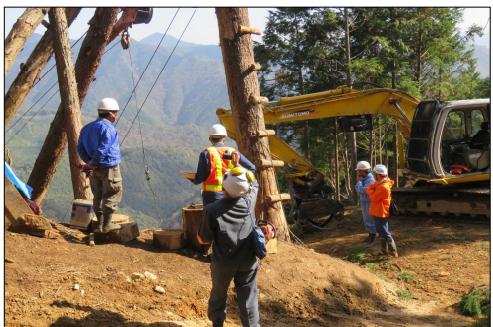
現場でのパトロールの様子
