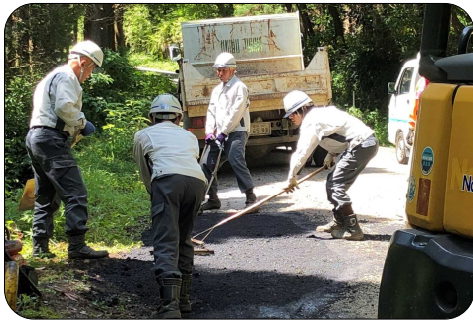
陥没した路面の補修作業の様子
