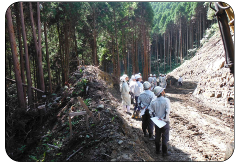
林道新設現場で安全チェック
