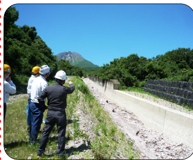
治山施設（導流堤）機能を説明
