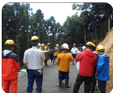
林道工事箇所で概要説明する職員
