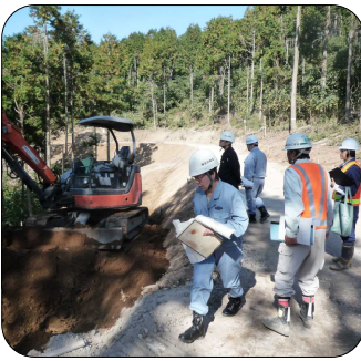
加治木労基署による安全点検
