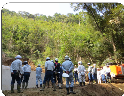
治山復旧工事現場での安全点検
