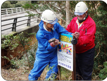
新たに不法投棄防止看板の設置
