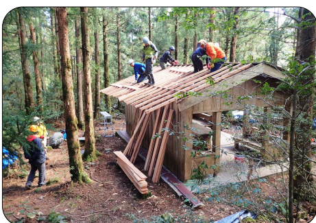
ボランティアにて屋根補修
