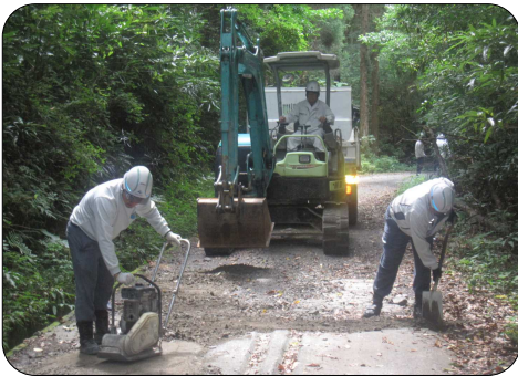
路面補修の様子
