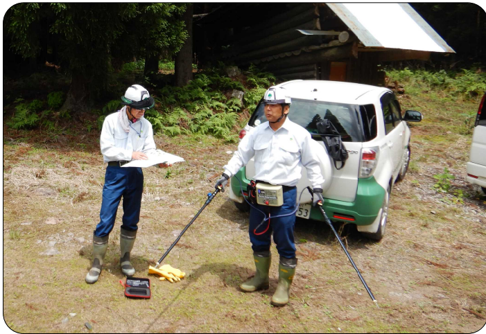
電気止め刺し作業手順説明の様子
