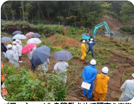
パワーショベルを稼働させて調査を実施
