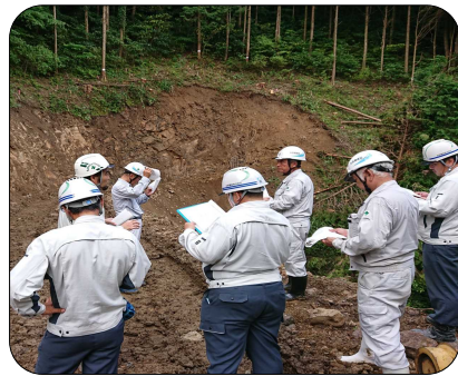
現地安全パトロールの様子
