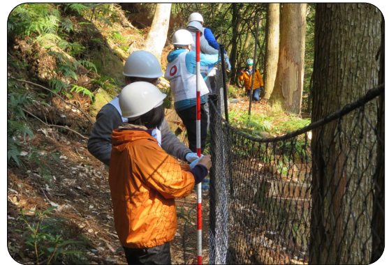
シカネット設置の様子
