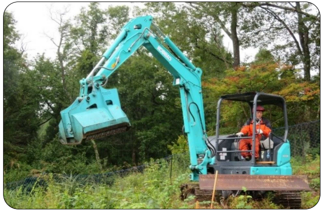
機械の稼働状況
