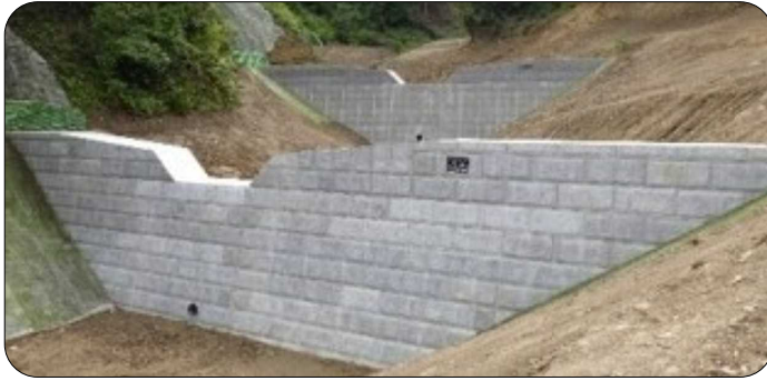
溪流荒廃地の復旧状況：朝倉市
