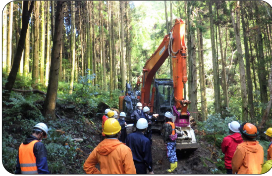
請負現場で安全パトロールを実施
