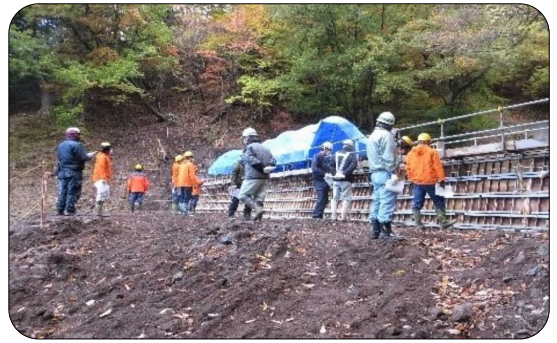
工事現場で安全パトロールを実施
