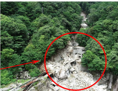
発電施設の被災状況
