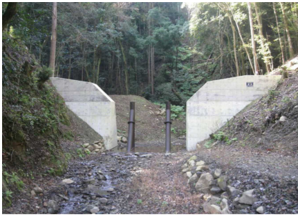
流木補足式谷止工の完成状況 (鹿児島県出水市)
