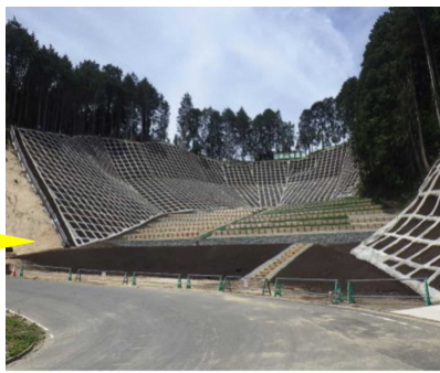
山腹工の完成状況
