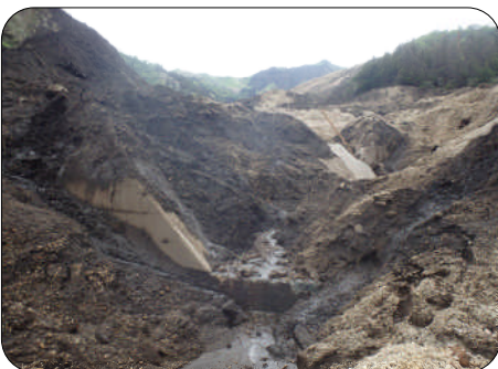
治山施設被害：南阿蘇村内早川
