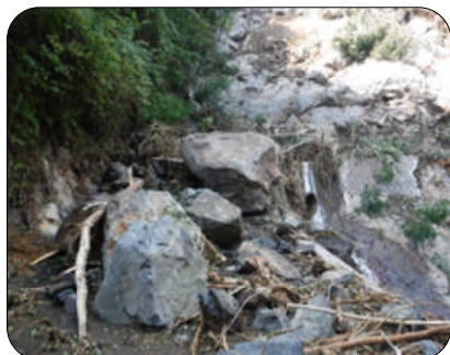
大雨による林道の被害
