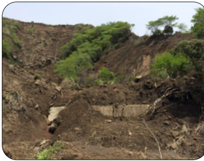
南阿蘇村の特定民有林直轄治山施設 災害復旧等事業箇所
