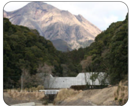
都城支署：荒襲治山工事
