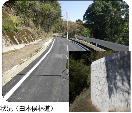
写真-11、12 被災後と復旧工事完成状況（白木俣林道）
