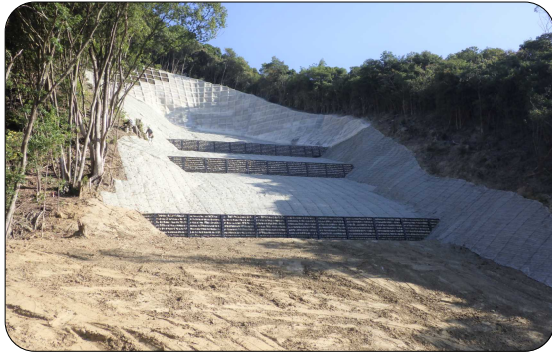
山腹工の完成状況（熊本県芦北町（民有林））
