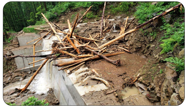
谷止工の流木補足状況（宮崎県串間市）
