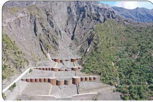
溪間工の設置状況（引の平）
