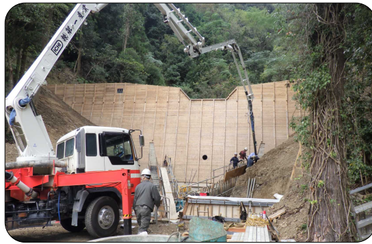
溪間工の施工状況（熊本県芦北町（民有林））
