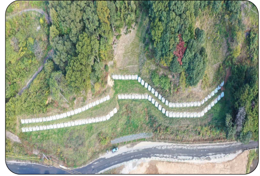
山腹工の完成状況（福岡県朝倉市（民有林））
