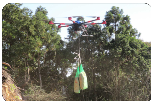
写真-10 ドローンによる資材運搬
