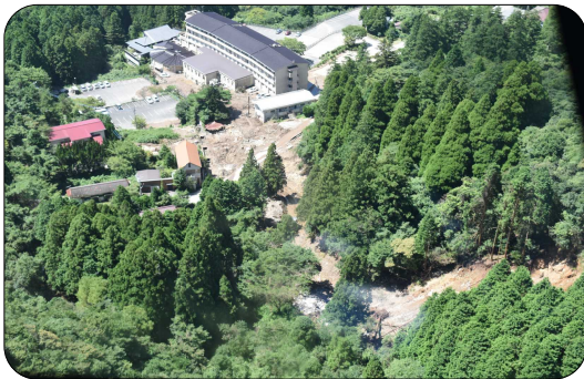
令和3年8月の豪雨による隣地被害の状況 (長崎県雲仙市 (国有林・民有林))
