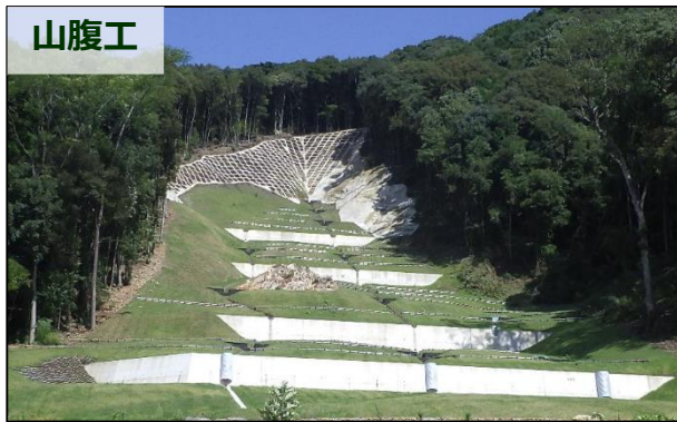
土砂の移動を抑え、植栽した樹木がしっかりと根を張れるよう、崩壊した斜面の安定を図ります。(芦北町：局)
