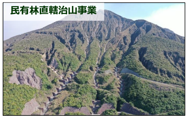
事業規模が特に大きい場合等であって、県からの要請があった時には、民有林においても治山事業を実施しています。(鹿児島市（桜島）：鹿児島署)
