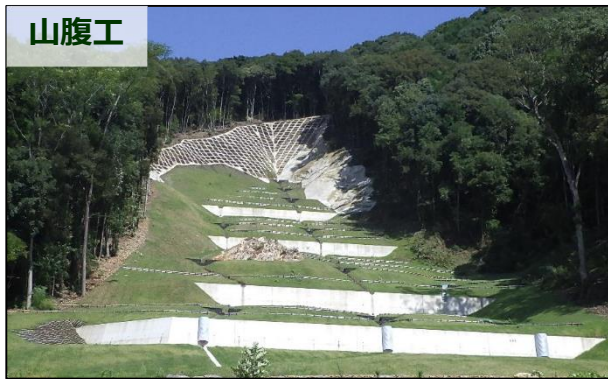
土砂の移動を抑え、植栽した樹木がしっかりと根を張れるよう、崩壊した斜面の安定を図ります。(芦北町：局)
